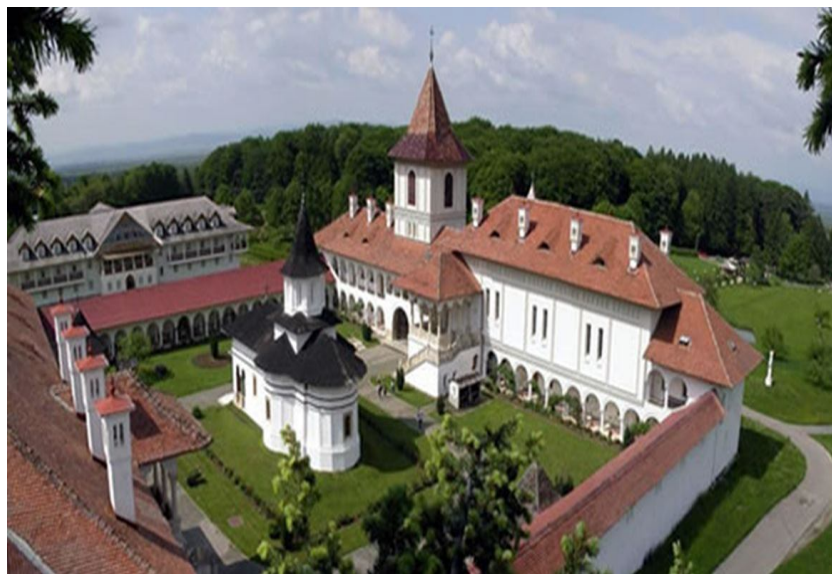
Complexul arhitectural de la Sâmbăta de Sus
